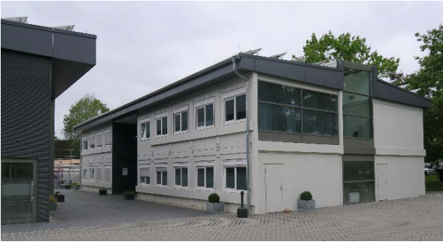
Abbildung 4: Energieeffizienz-Gebäude auf dem IKC mit hocheffizienten PV-Modulen, Büro- und Besprechungsräumen, Infrartheizungsanlagen, und modernen Dämmstoffen
